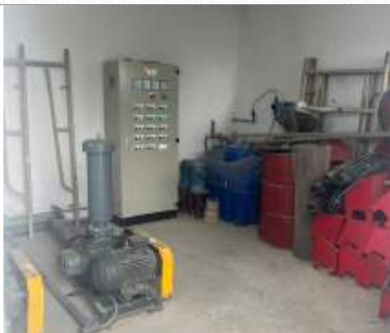
Hình 14. Trạm xử lý nước thải tập trung công suất 80 m 3 /ngày.đêm của đơn vị cho thuê nhà xưởng
