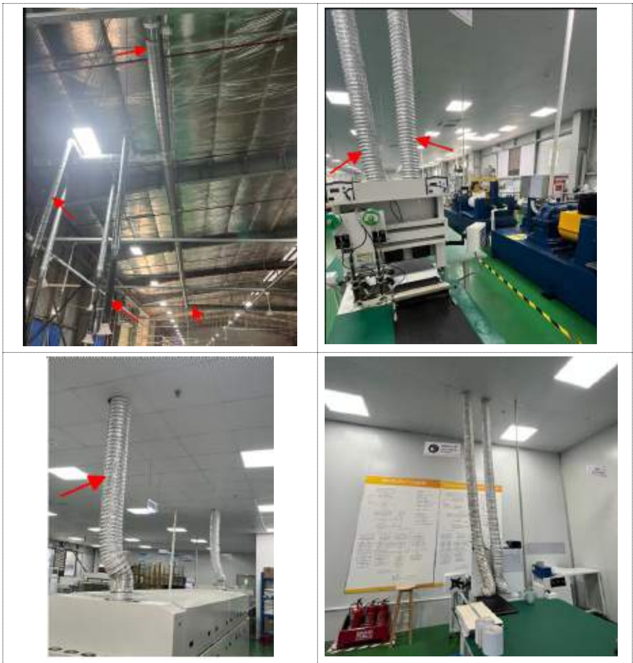
Hình 16. Hệ thống thu gom khí thải trước khi xử lý
